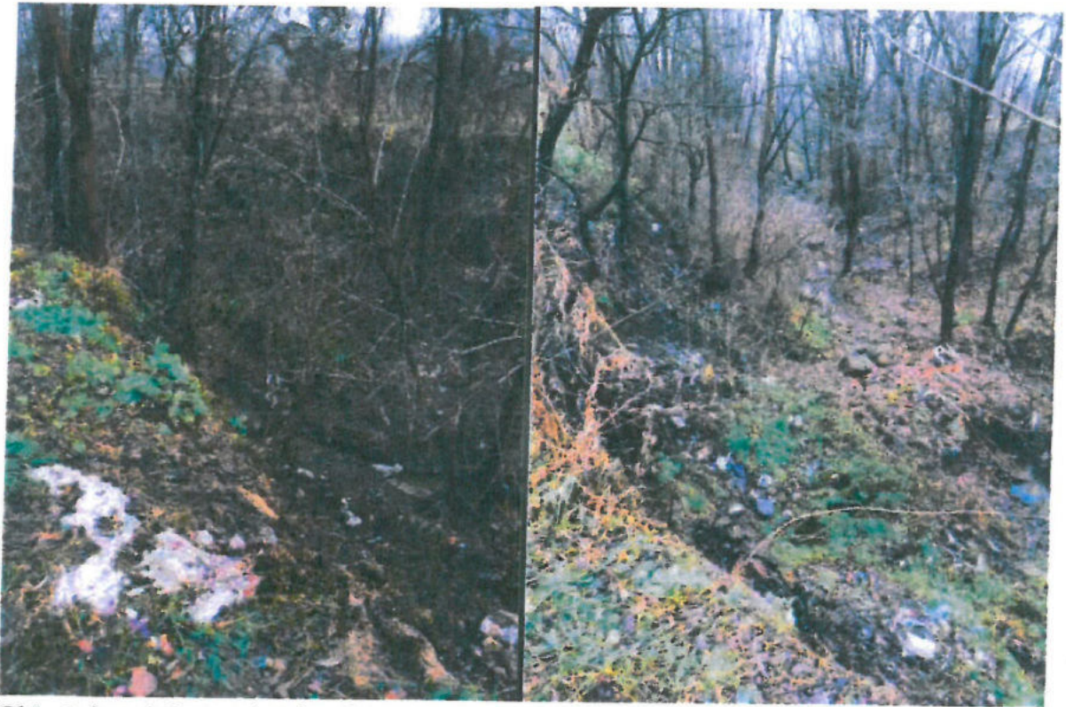
Obiectul nr. 3 Protecție taluz drum în sat Averesti
